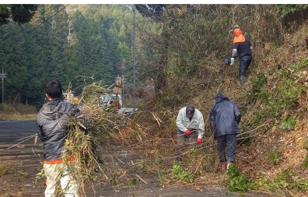
旧相渡小学校下の約60mの支障木を半日で処分。寒い朝でしたが皆さん汗をかいて作業されました。
